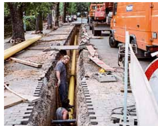
Verlegung einer Gasleitung Ende der 1990er Jahre.
